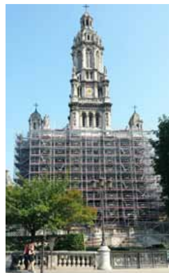
Sainte-Trinité, travaux enfin commencés
