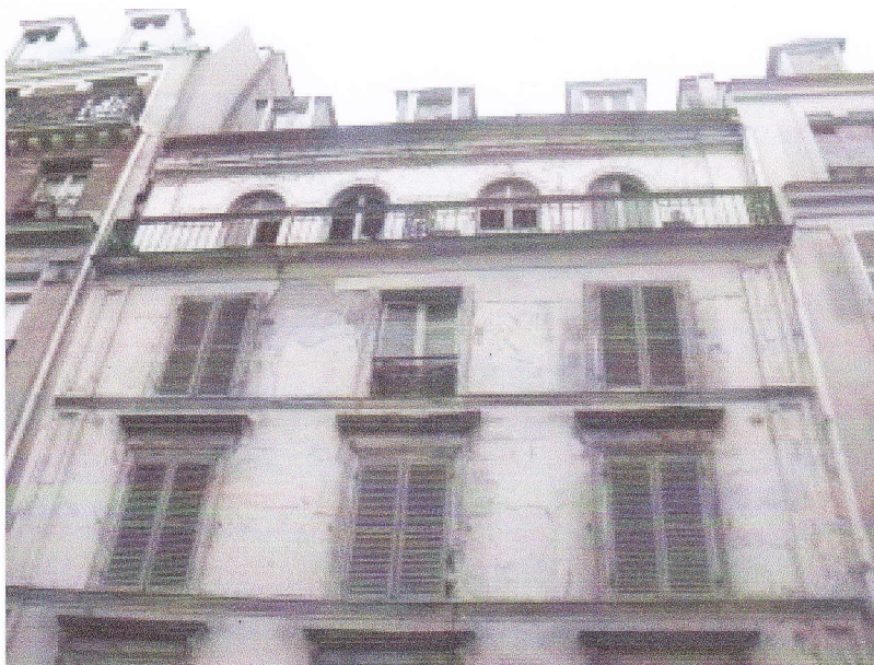
Façade du 5 rue Myrha, partie haute (novembre 2011).
