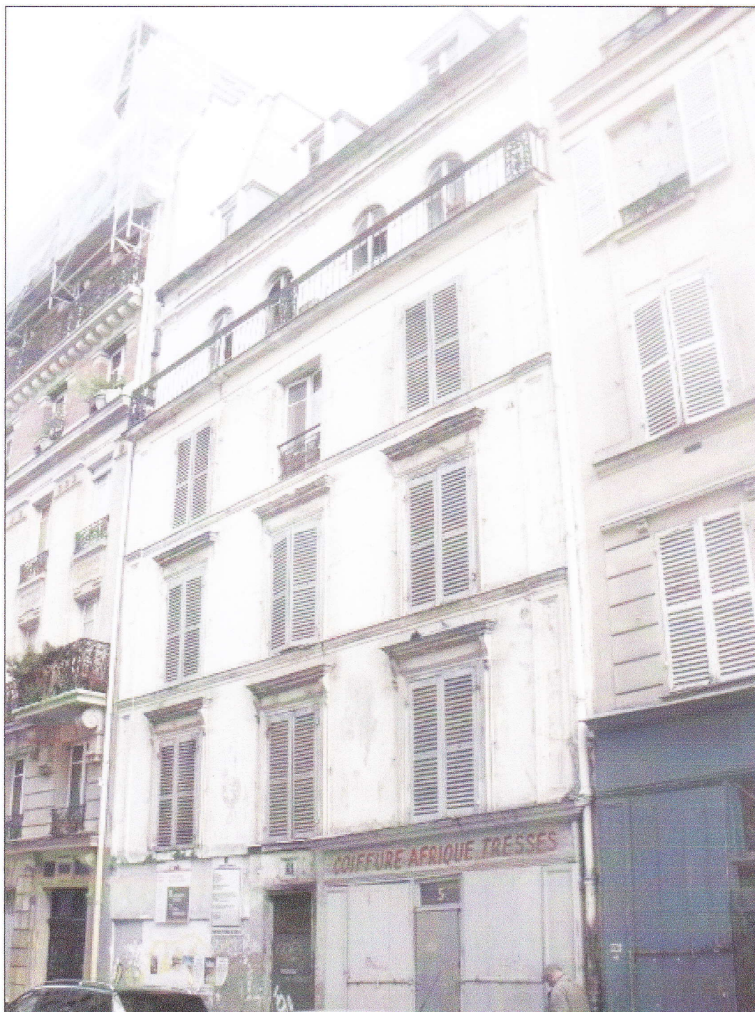
Façade du 5 rue Myrha (juin 2011).
